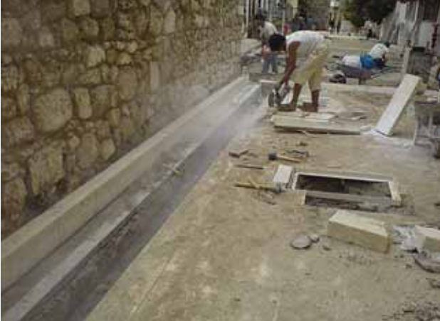
Yol Kaplama Çalışmaları ve Yağmur Suyu Kanalı (Hesapçı Sokak)
