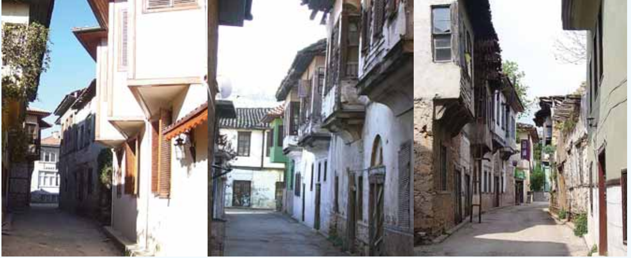
Kaleiçi Sokakları ve Çıkmaları (Yenikapı Sokak, Hamit Efendi Sokağı, Karanlık Sokak)
