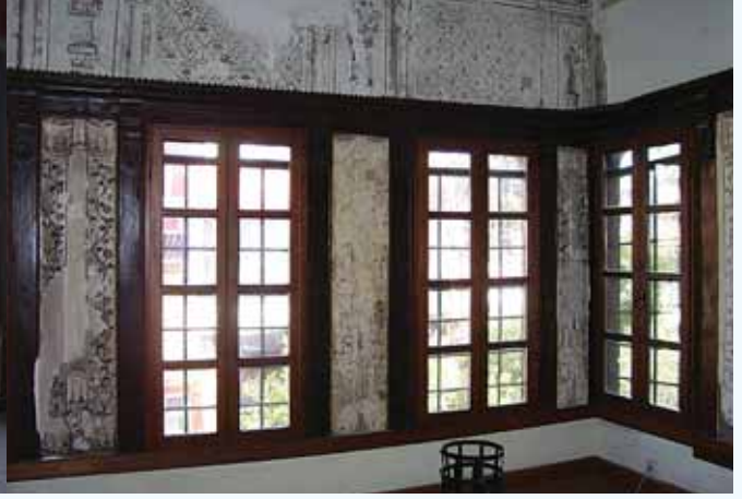
Duvar Süslemeleri (Mermerli Banyo Sokak, 3 No'lu Ev, Gizli Bahçe Konakları)
