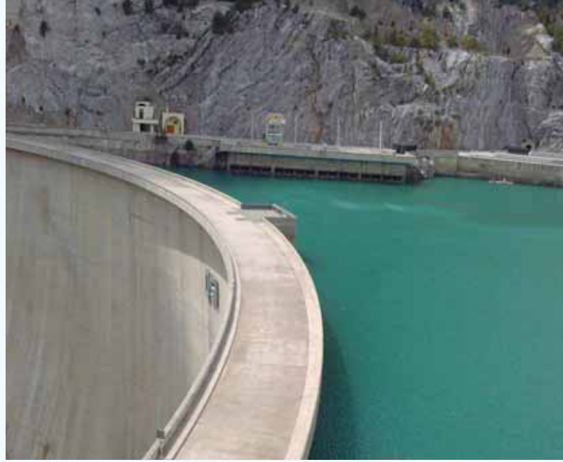
Manavgat Oymapınar Barajı. Foto: A. Kerim ATILGAN
