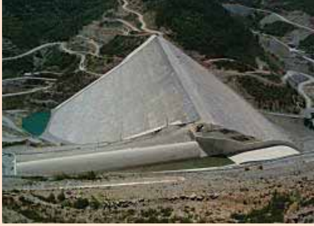
Dim Barajı ve HES
