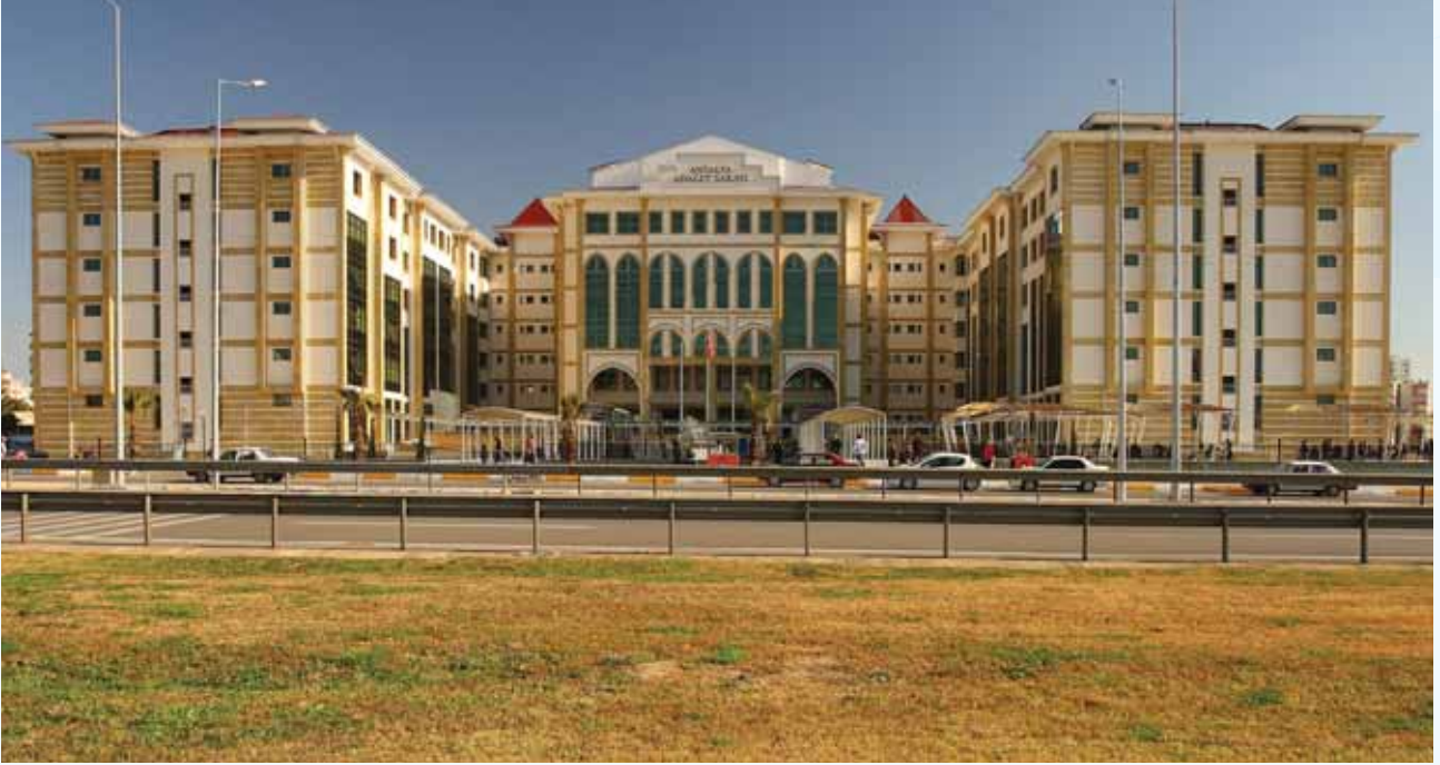
Antalya Adliyesi Hizmet Binası- Foto: (M.DÖNMEZER)-2009
