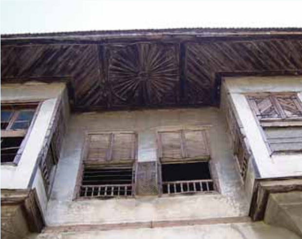
Mermerli Banyo Sokak, 3 No'lu Ev
