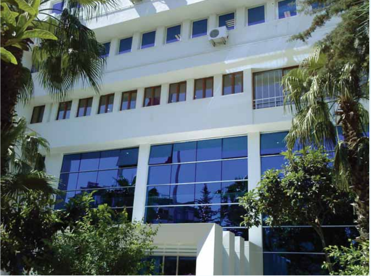
Sosyal Güvenlik İl Müdürlüğü Hizmet Binası-2010
