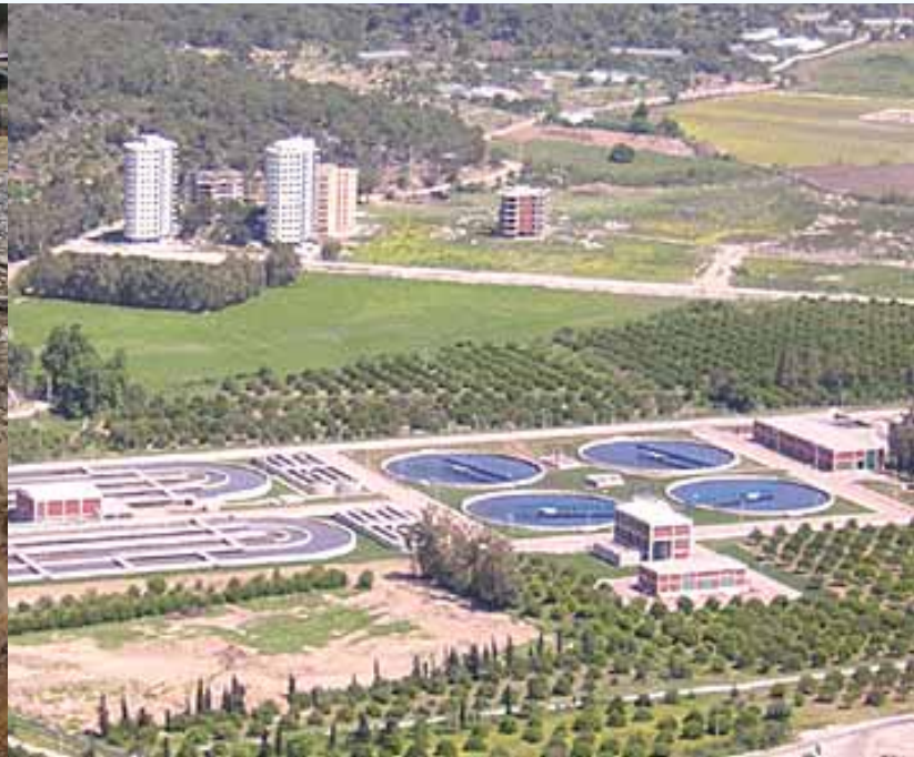
Konyaaltı-Hurma Arıtma Tesisi
