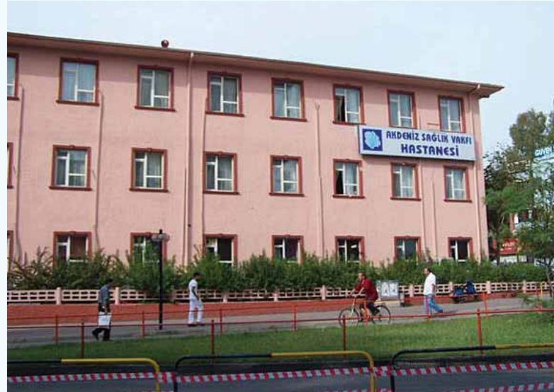
Yıkılan Vakıf Hastanesi (Eski Doğumevi Hastanesi)
