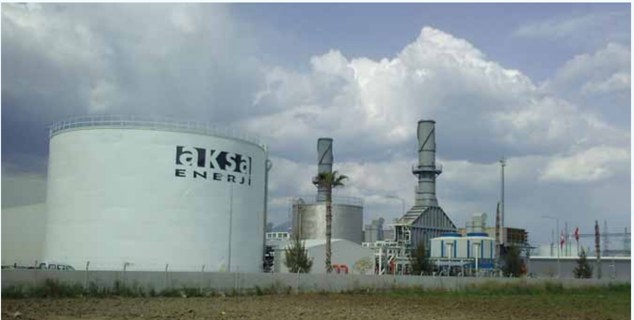
Antalya - Döşemealtı, Doğalgazdan Elektrik Üretim Santrali
