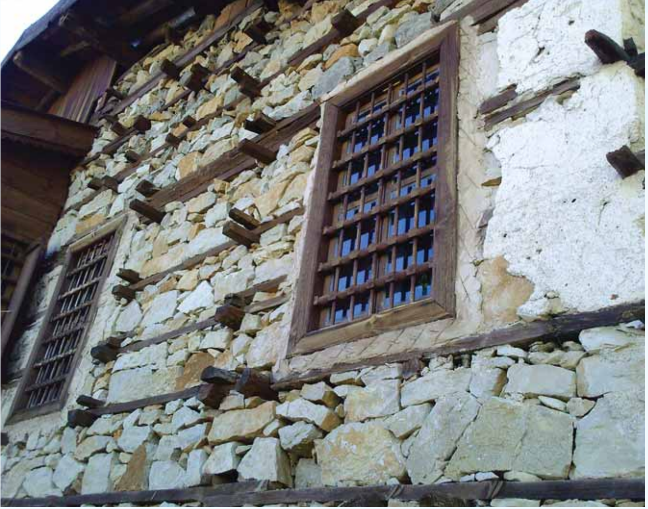
Akseki-Sarhacılar Köyü-Tarihi Ev. (Foto: A.Kerim ATILGAN-2010)
