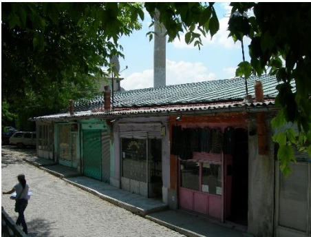
Kuzey Cephe, 2007 (Görsel: Kütahya Vakıflar Bölge Müdürlüğü)
