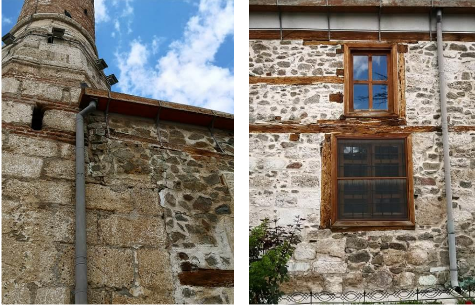
Cephe malzemelerinde yaęmur suyunun neden olduęu bozulmalar, 2021 (Görseller: BAYKAL Pınar, Kültür ve Turizm Bakanlığı)
