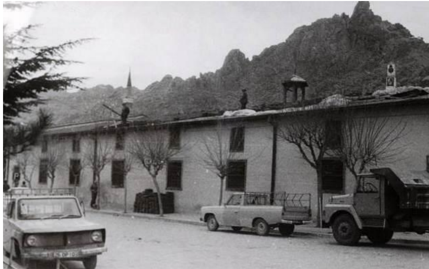
Restorasyon öncesi Güney Cephe (Görsel: Kütahya Vakıflar Bölge Müdürlüğü)
