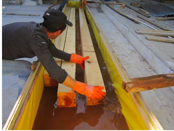
Ahşap Elemanlarda Emprenye İşlemleri, 2013 (Görsel: Kütahya Vakıflar Bölge Müdürlüğü)
