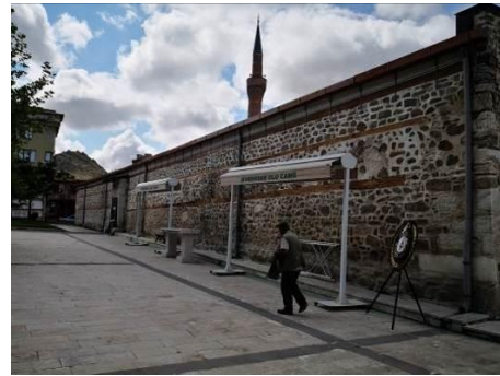
Restorasyon sonrası Kuzey Cephe, 2021 (Görsel: BAYKAL Pınar, Kültür ve Turizm Bakanlığı)
