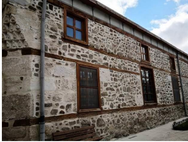
Güney Cephe, 2021 (Görsel: BAYKAL Pınar, Kültür ve Turizm Bakanlığı)
