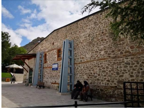
Batı Cephe- Çelik Destekler, 2021 (Görsel: BAYKAL Pınar, Kültür ve Turizm Bakanlığı)
