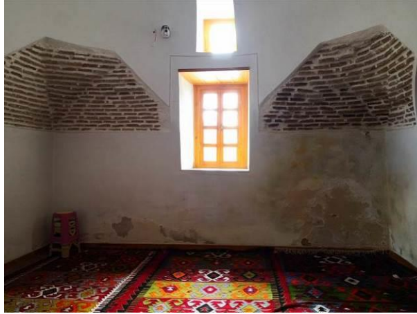
İç cephelerde neme bağlı bozulmalar, 2021 (Görsel: BAYKAL Pınar, Kültür ve Turizm Bakanlığı)
