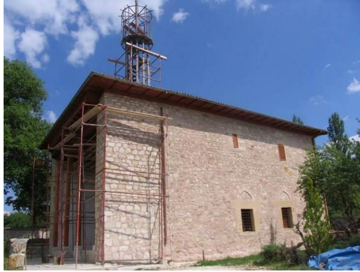
2005 restorasyonu sırasında minarenin yapım aşaması (Görsel: Vakıflar Genel Müdürlüğü)
