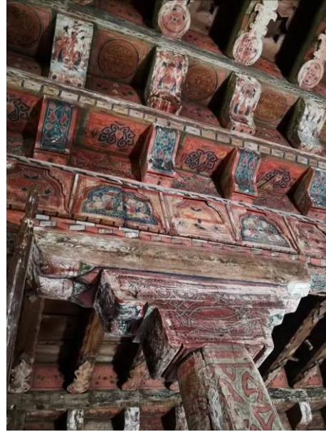
Ahşap tavan konstrüksiyonu ve kalem işi süslemeler, 2021 (Görseller: BAYKAL Pınar, Kültür ve Turizm Bakanlığı)
