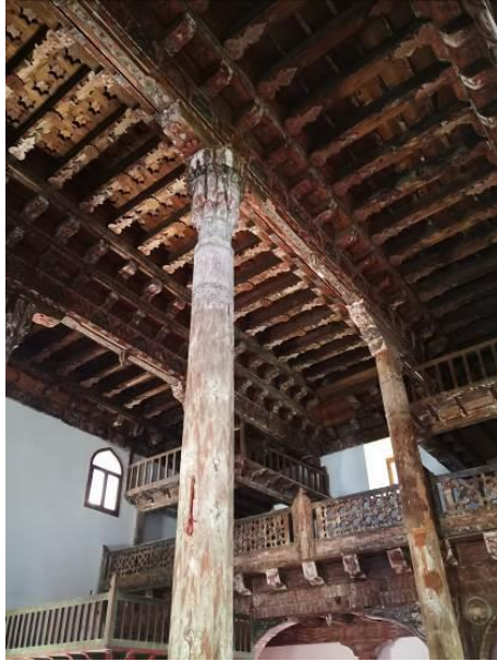
Ahşap tavan konstrüksiyonu ve kalem işi süslemeler, 2021 (Görseller: BAYKAL Pınar, Kültür ve Turizm Bakanlığı)
