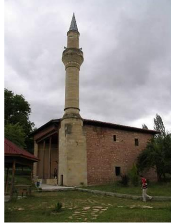
Restorasyondan önce Minare, 2015
