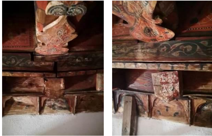
Üst yapıdaki deformasyonlar, 2021 (Görseller: BAYKAL Pınar, Kültür ve Turizm Bakanlığı, 2021)
